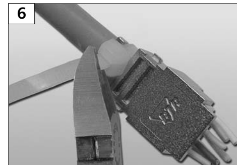
Kabelbinder zur Zugentlastung anbringen und Überlänge entsprechend abschneiden. Fit a cable tie and cut off the excess length.
