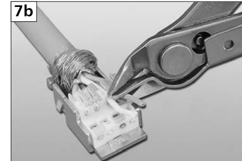
... und die Kabeladern bündig abschneiden. ... and cut the wire ends flush.
