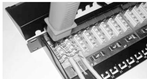
Drücken Sie die Abschirmung zum Kontakt mit der Masse an und halten Sie das Kabel gerade.
