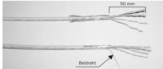
Isolieren Sie ca. 50 mm der Kabelummantelung ab, falten Sie die Abschirmung nach hinten und trennen Sie die Adern in jeweils 4 Paare.
