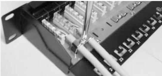
Ziehen Sie die Schrauben durch das Metallgehäuse fest an, um gleichzeitig zwei Kabelummantelungen zu halten.
