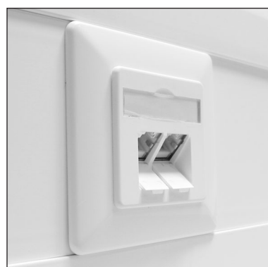
Einbau im Brüstungskanal.
