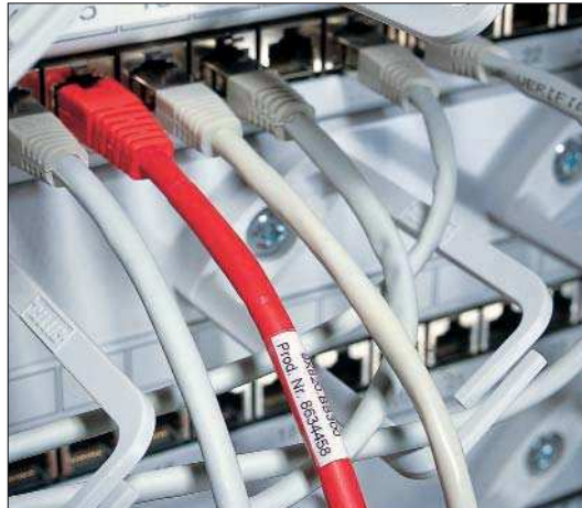
Selbstlaminiierende Etiketten bieten Schutz gegen Abrieb und Umwelteinflüsse.
