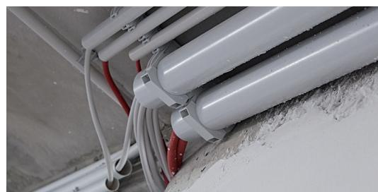
Durch das funktionelle Stecksystem werden mehrere EC Euro-Clips in unterschiedlichen Größen verbunden.
