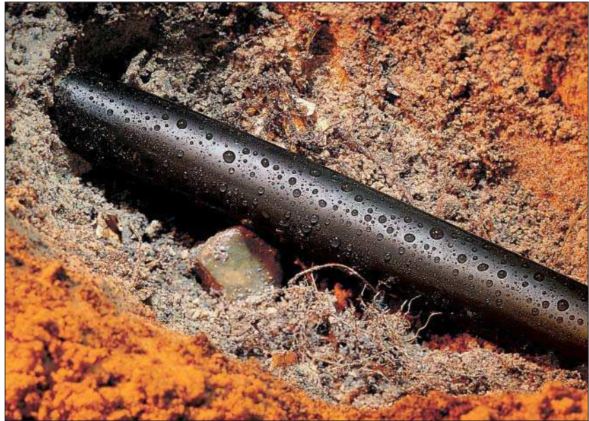
TREDUX HA47 – Einsatz im Erdreich.
