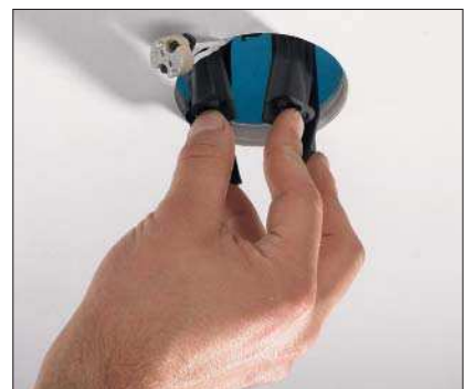
Die 4 flexiblen Montagelaschen rasten leicht in die gewünschte Position ein.
