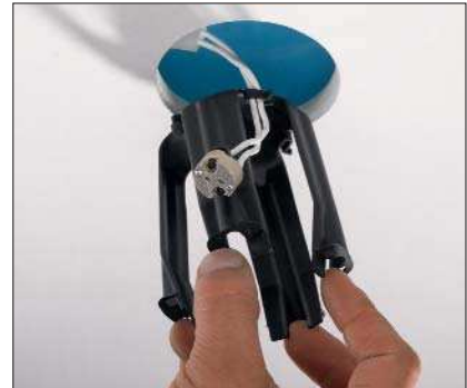
Zuleitung befestigen, Montagelaschen zusammendrücken und in die Deckenaussparung einsetzen.
